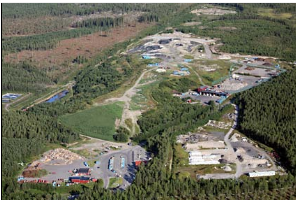
Bild 1. Flygbild över Bredviksbergets avfallsanläggning i Öjebyn, Piteå kommun.
